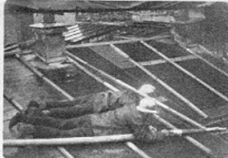
17 h. 25. Inutilité dans le coin de l'immeuble, les policiers arrêtent l'appartement par les fenêtres. Mais la famille continue à partir en masse. Une quinzaine de pompiers dévalent alors de hauteur sur le toit de l'immeuble et espèrent l'entraîner de violence.
